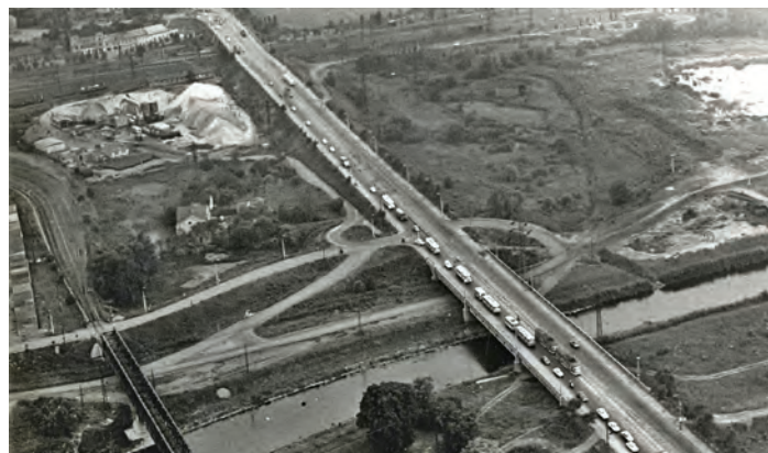
Letecký pohled na mosty nahrazující železný most z roku 1898
