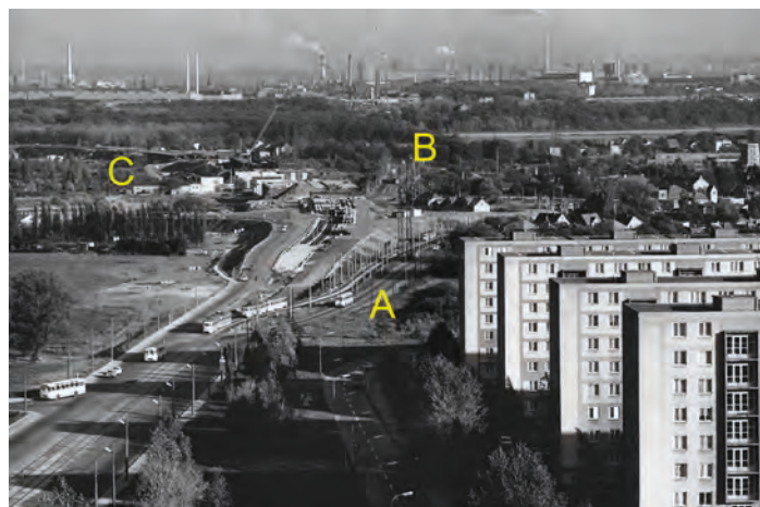
Letecký snímek zachycující výstavbu současných mostů
