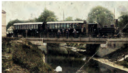
Nový most přes Porubku
